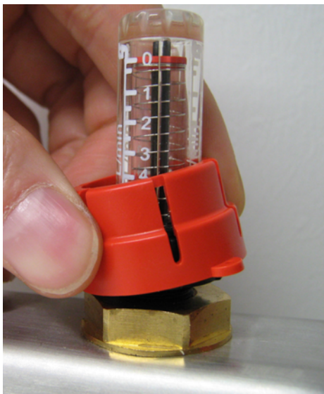
KUVA 3. Virtausmittarin lukitusosan poisto.
