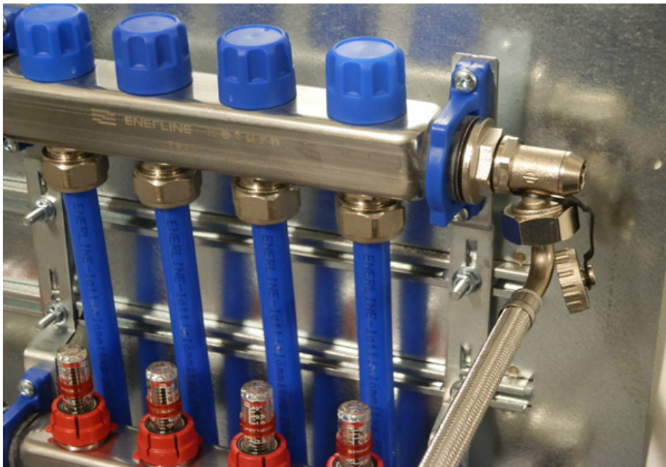
Bild 2. Avluftningsslang ansluten till avluftningsänden.
