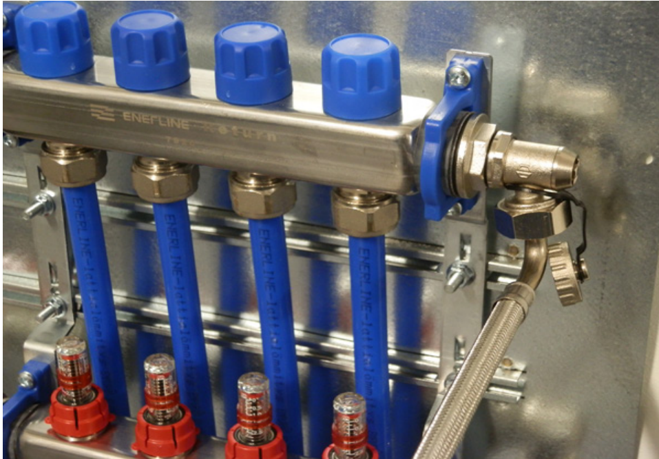
Kuva 2. Ilmausletku kytkettynä ilmauspäätyyn.
