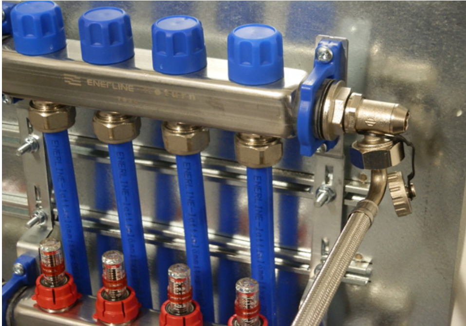
Kuva 2. Ilmausletku kytkettynä ilmauspäätyyn.
